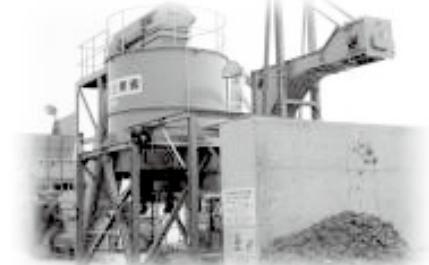
固形燃料施設 (廃プラ・木くず・紙くず)
