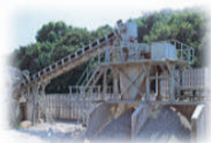
再資源化施設 (コンクリートくず・アスファルトくず)
