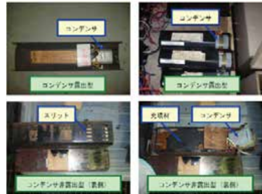
図3 コンデンサ外付け型安定器の例(原則禁止)
