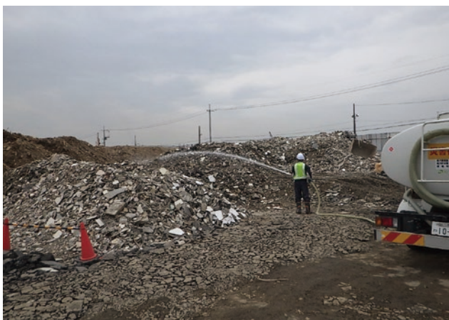
保管廃棄物への散水
