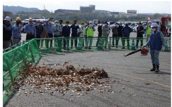
ネット付きバリケードの設置②
