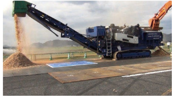
木くずの破碎処理
