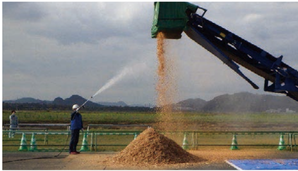
粉じん対策としての散水
