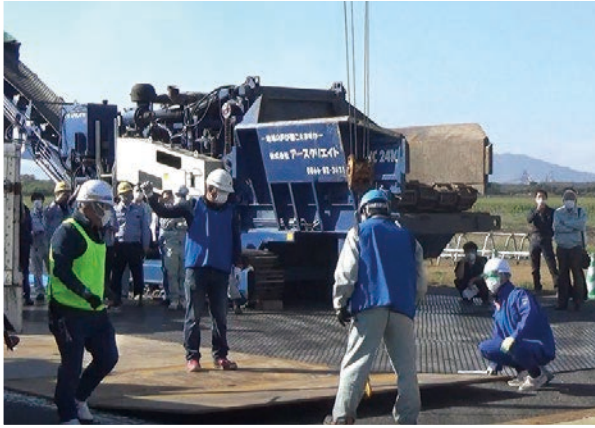
敷鉄板の敷設
