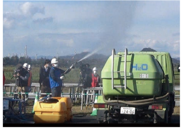
散水用資機材の設置
