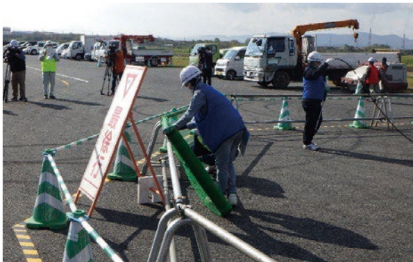
ネット付きバリケードの設置①
