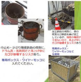
加工鉄筋の吊りには、鉄の荷重がゴケ筋を曲げ加工しているが、強度の確保ができないので、吊上げ時にカゴが破壊するリスクあり。
